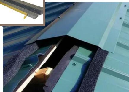
**Уплотнитель конька – лента на основе вспененного полиуретана, пропитана водоотталкивающей и акриловой дисперсией.**
