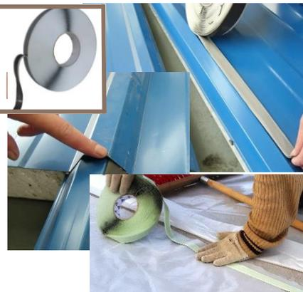
**Соединительная Лента Липент О –** самоклеящаяся герметизирующая бутиловая лента с двухсторонней рабочей поверхностью
