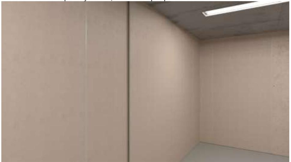
Все стыки и места примыканий промазываются акустическим герметиком.
