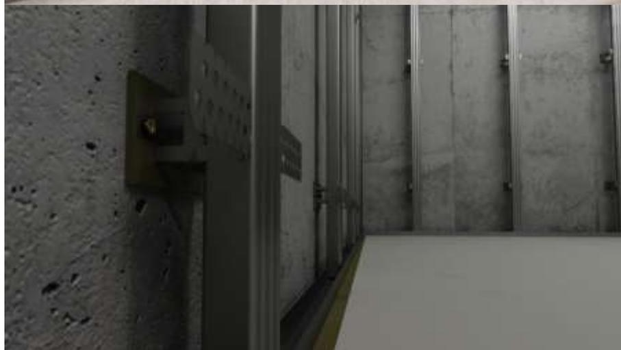
С помощью шумопоглощающего материала, к примеру, минеральной ваты, заполняют внутреннюю часть профиля. На обратную сторону листа ГКЛ наклеиваем материал Липлент Зик. Если материал не имеет клеевого слоя, то лист ГКЛ предварительно следует обработать контактным клеем Липлент К
