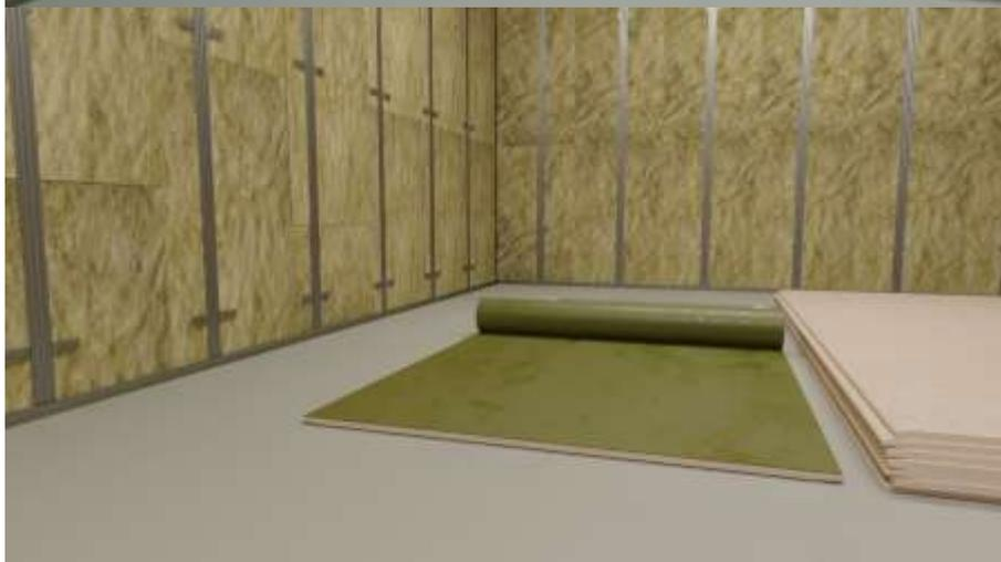
Далее лист с наклеенной мембраной ставится на виброизоляционную ленту, выступающую из-под направляющего профиля, прижимается к каркасу и фиксируется саморезами.
