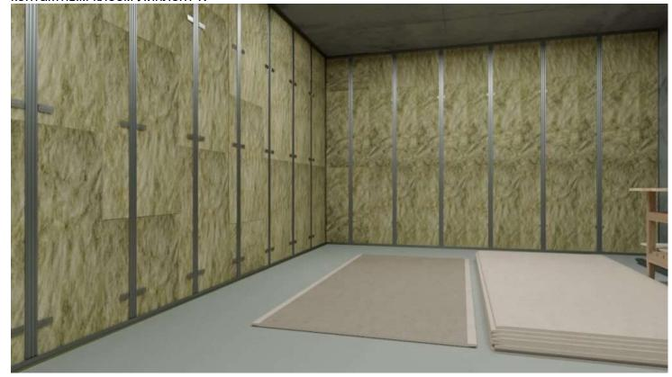
Далее лист с наклеенной мембраной ставится на виброизоляционую ленту, выступающую изпод направляющего профиля, прижимается к каркасу и фиксируется саморезами.
